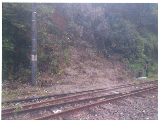
⑤北河内～椋野間 14K850M付近 土砂流出 線路脇の沢から小規模な土砂流出
